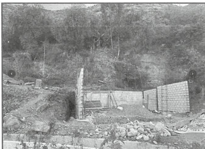
Figura 7.5.15. Punto Crítico PC-06. Vista del Punto Crítico PC-06, donde se observan excavaciones y edificaciones en ejecución sobre la ladera, así como zonas con suelo expuesto y evidencia de erosión superficial. Estas intervenciones modifican las condiciones naturales del talud y podrían comprometer su estabilidad, por lo que se recomienda implementar medidas de estabilización geotécnica, control del drenaje y monitoreo permanente para prevenir afectaciones al canal de conducción
