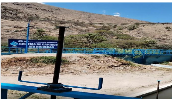
CAPTACION RIO HIGUERAS – CANCHAN EPS SEDA HUANUCO SA
