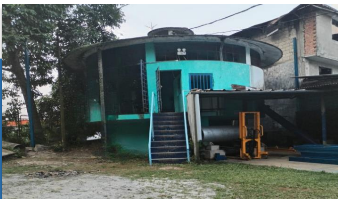
POZO CAISSON – TINGO MARIA EPS SEDA HUANUCO SA
