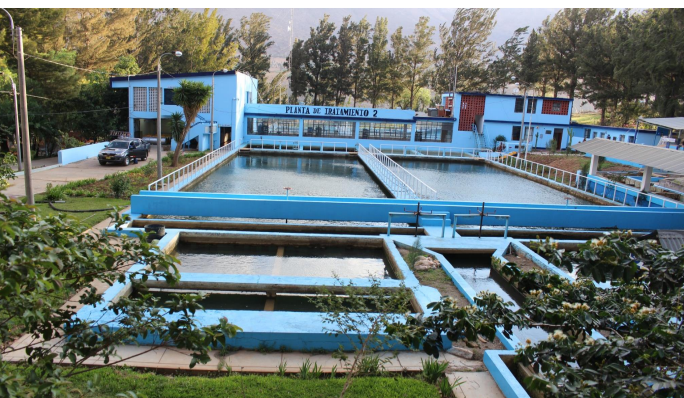
PLANTA DE TRATAMIENTO – CABRITOPAMPA EPS SEDA HUANUCO SA
