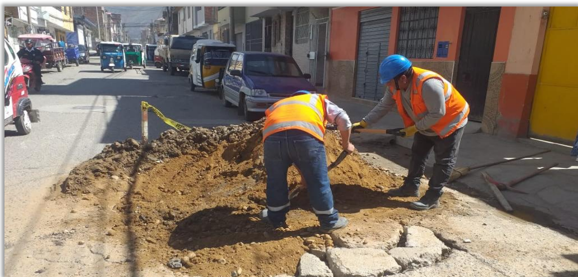
OPERARIOS EFECTUANDO TRABAJOS DE REPARACIÓN
